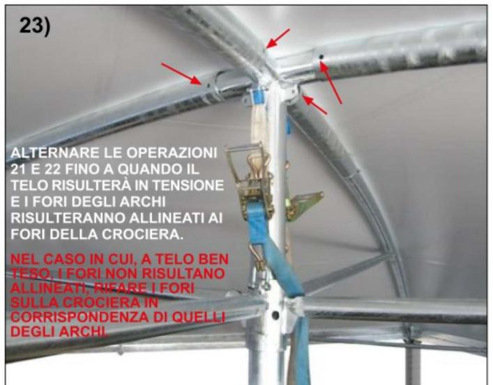
ALTERNARE LE OPERAZIONI 21 E 22 FINO A QUANDO IL TELO RISULTERÀ IN TENSIONE E I FORI DEGLI ARCHI RISULTERANNO ALLINEATI AI FORI DELLA CROCIERA.
