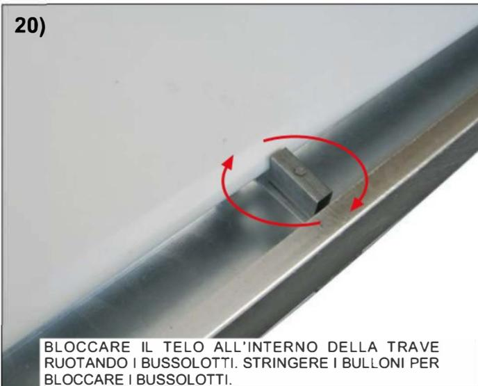
BLOCCARE IL TELO ALL'INTERNO DELLA TRAVE RUOTANDO I BUSSOLOTTI. STRINGERE I BULLONI PER BLOCCARE I BUSSOLOTTI.
